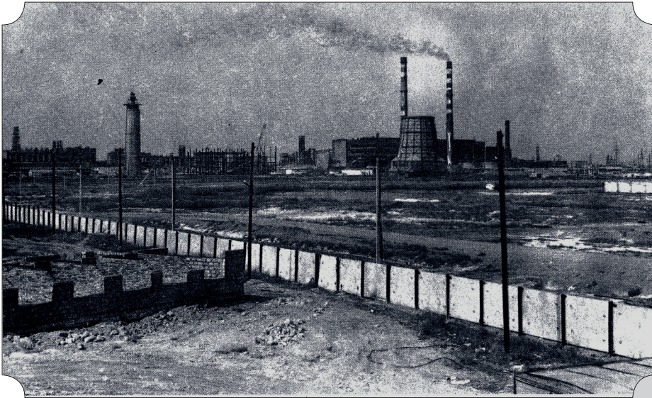
Гурьевская ТЭЦ. I-IV очередь
